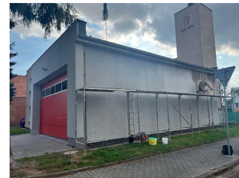
Fasádní nátěr hasičské zbrojnice.
