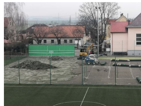
Rekonstrukce multifunkčního hřiště.
