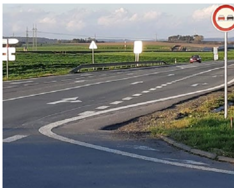
Konečně došlo i na vybudování odbočovacího pruhu u hřbitova – první jednání o možnosti zřídit odbočovací pruh se ŘSD proběhlo už v roce 2010.
